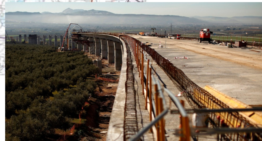
Obras del AVE Madrid-Lisboa
